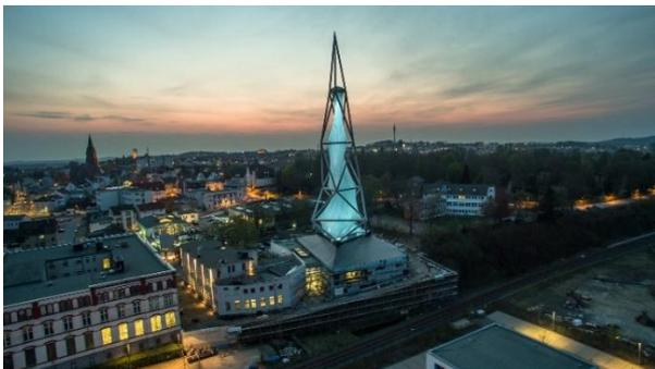
*Umbau und Erweiterung des **Phänomena Science Centers** in Lüdenscheid mit Neubau eines 75m hohen Stahlturmes in Fachwerkbauweise im Zusammenhang mit dem Förderprogramm „Regionale 2013“*
